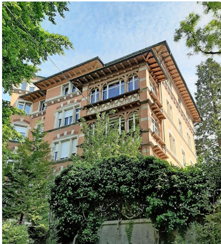
Die schicke Liegenschaft an der Hochstrasse 60A wird gegenwärtig noch von der ETH genutzt. Bild: Martin Kreutzberg
